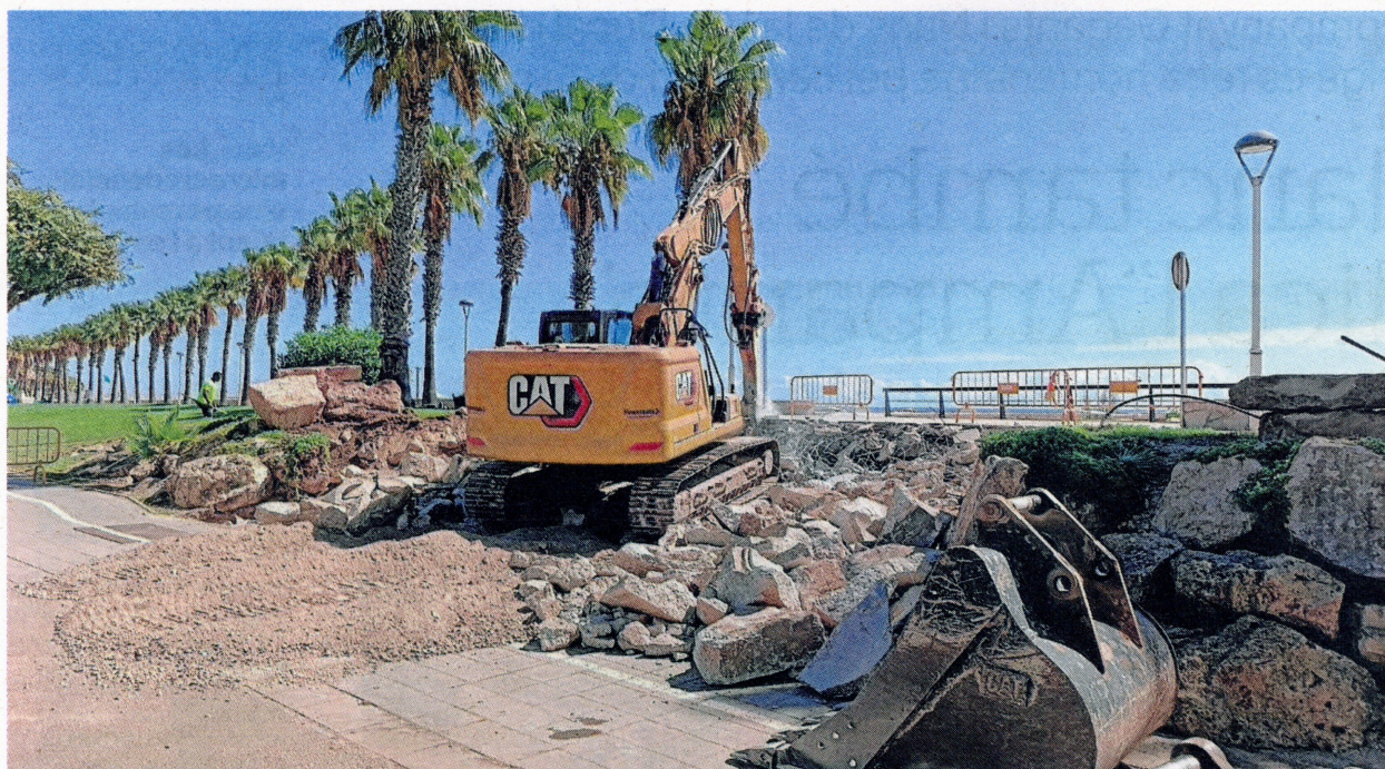
Màquines excavadores treballant a l'espai aquesta setmana, al passeig marítim de les Cases d'Alcanar. FOTO: SUBDELEGACIÓ DEL GOVERN
