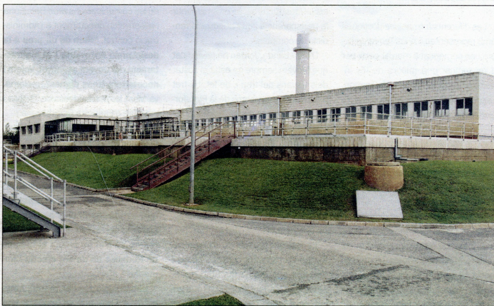
El CAT projecta la construcció d'un segon dipòsit d'aigua sense tractar a la planta de l'Ampolla. /ARXIU
