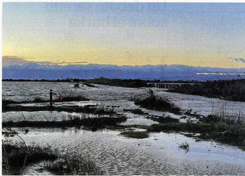
La intrusió d'aigua marina va ser causada per trencaments en diferents punts dèbils. FOTO: AJUNT. DE DELTEBRE
