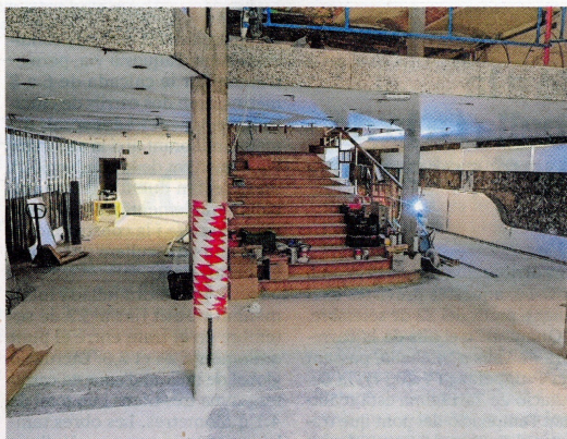
Estat de les obres per adequar el nou centre d'interpretació, de dues alçades. FOTO: JOAN REVILLAS
