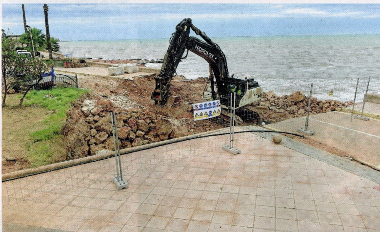
Màquines excavadores retirant runa al final del barranc Sant Jaume, en el moment dels aiguats del 2021. FOTO: J. REVILLAS
