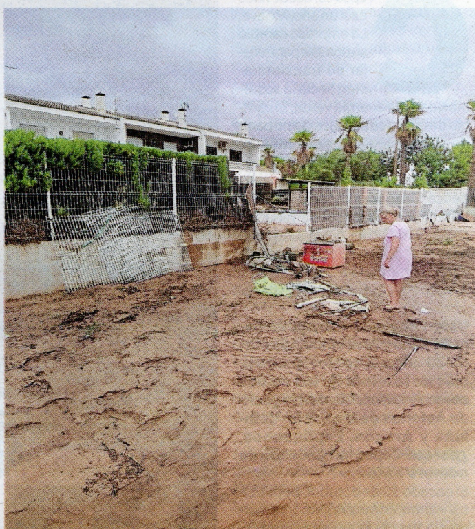
Desperfectos en viviendas de Alcanar (Montsià), provocados por las inundaciones de septiembre de 2023. FOTO: JOAN REVILLAS
