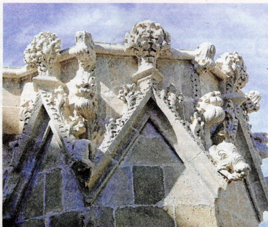
La coberta té una gran quantitat de detalls, elements i gàrgoles que s'estan restaurant. FOTO: J. REVILLAS
