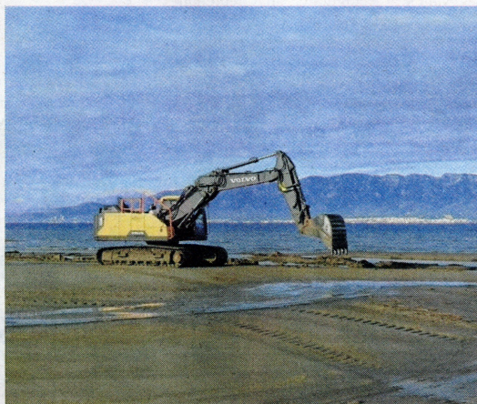
Maquinària treballant sobre el terreny per reparar el trencament.
