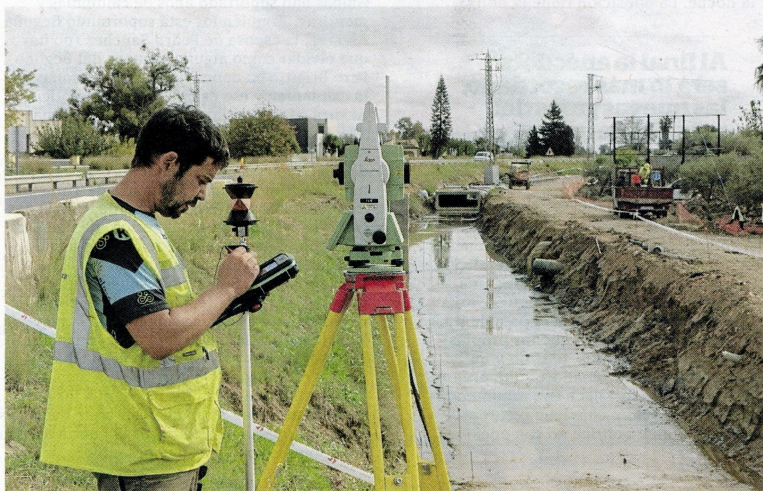
Obres en marxa d'una nova fase de passeig del Carrilet, a Deltebre. FOTO: JOAN REVILLAS
