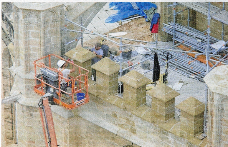
Treballs per restaurar la coberta de l'absis de la Catedral de Tortosa. FOTO: J. REVILLAS
