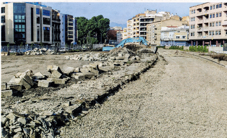
Les màquines excavadores avançant en els treballs, fa uns dies. FOTO: J. REVILLAS
