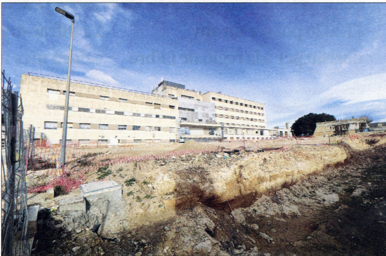
Este mes de gener se preveu que es reprenquen les obres d'ampliació de l'Hospital Universitari de Tortosa. / ARXIU
