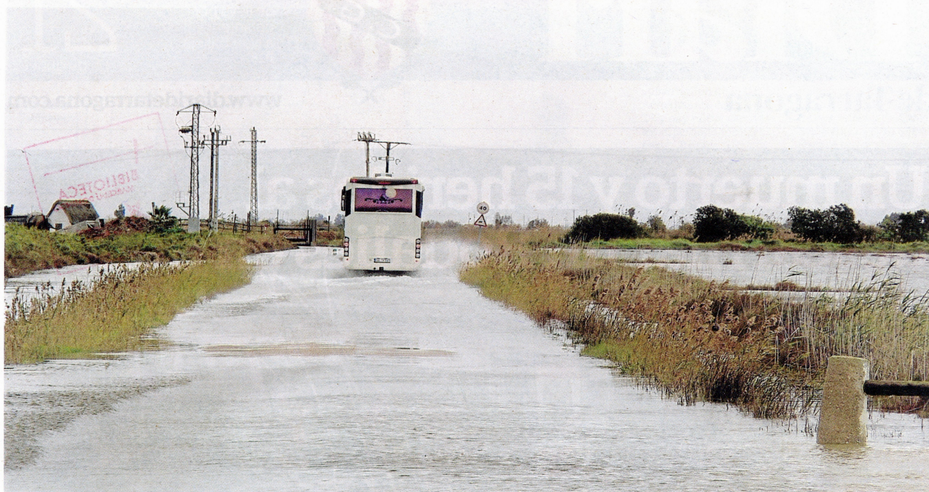
La carretera de los Eucaliptos al Trabucador, gravemente inundada ayer por la mañana. FOTO: JOAN REVILLAS
