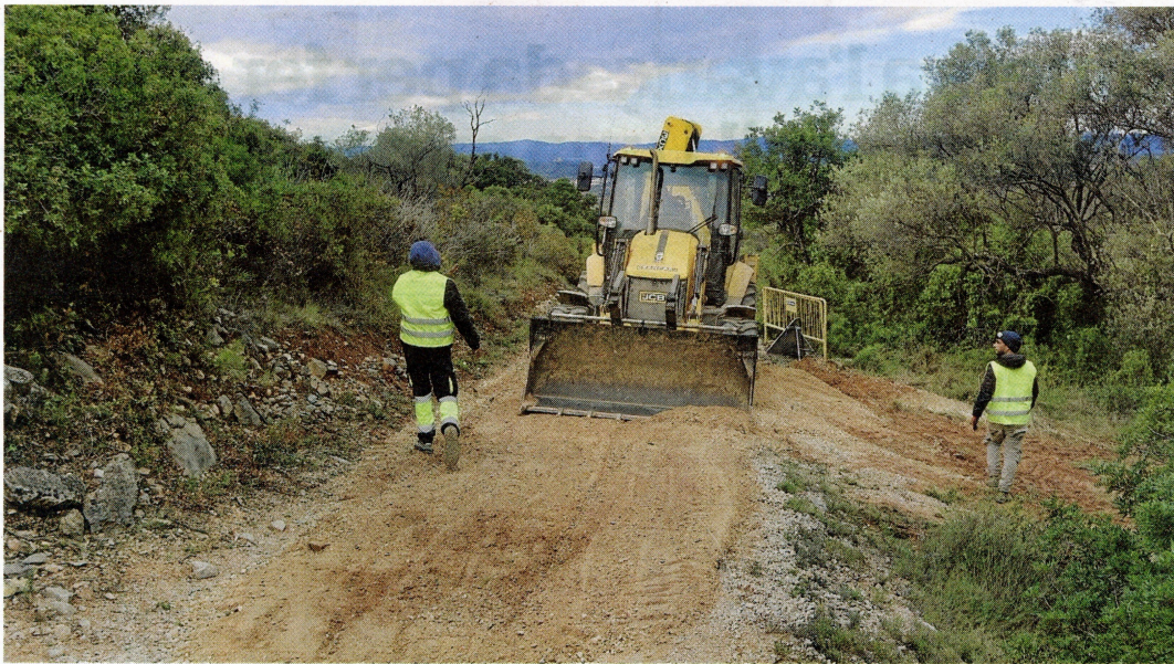
Obres d'arranjament d'un camí malmès pels últims aiguats, a la serra del Montsià. FOTO: JOAN REVILLAS
