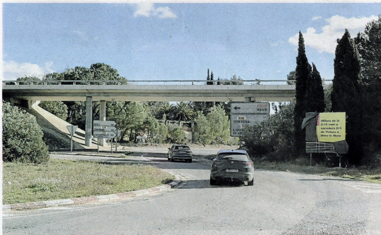
Un cartell ja anuncia les obres al primer tram de la C-12, a Móra la Nova. FOTO: JOAN REVILLAS
