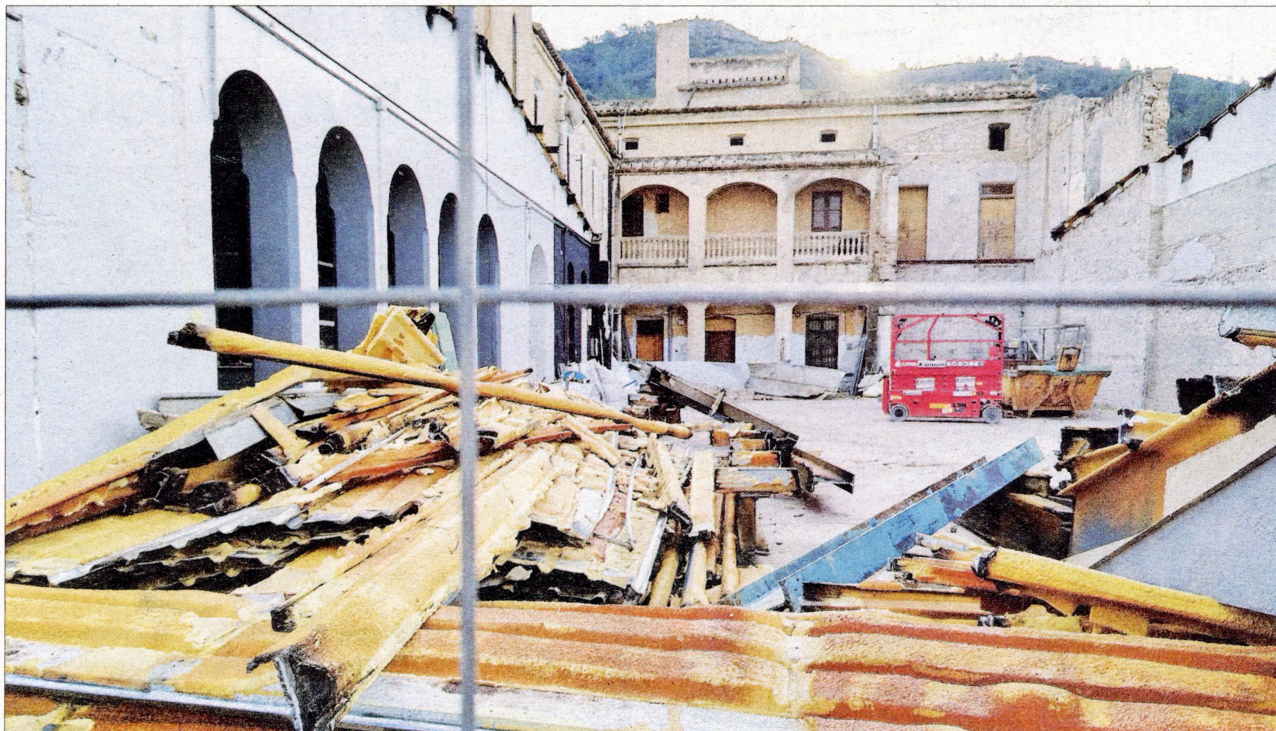
La primera fase de les obres consistix en la restauració dels tancaments de l'edifici i en l'enderroc de la nau del Casal que era una construcció afegida. /CEDIDA
