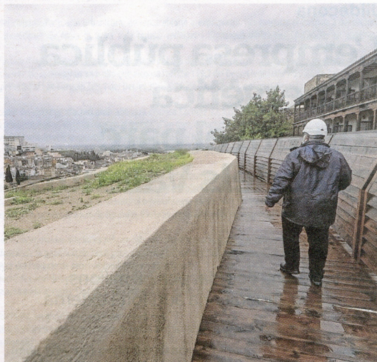
Recorregut per la muralla, amb una nova passarel·la. FOTO: J. REVILLAS
