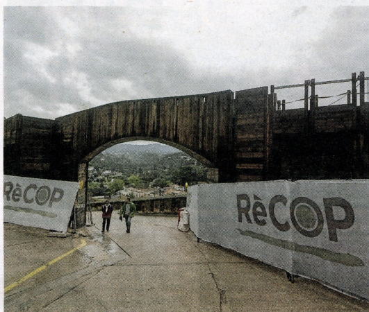
A l'entrada principal del Castell s'ha construït un nou arc de fusta.
