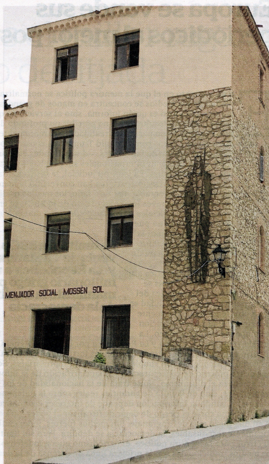
La nau central del complex dels Josepets que es rehabilitarà.
