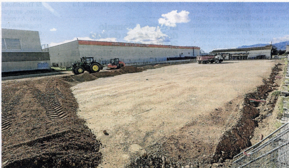
Obres de construcció del nou Ametller Origen, fa uns dies. FOTO: J. REVILLAS
