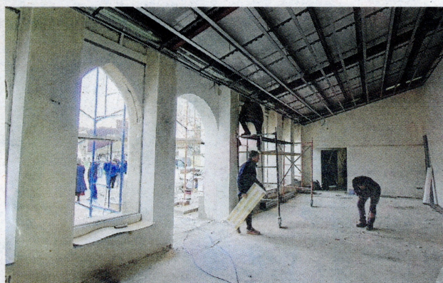
Operaris treballant a l'interior de l'edifici, que es trobava en un avançat estat de degradació. FOTO: JOAN REVILLAS
