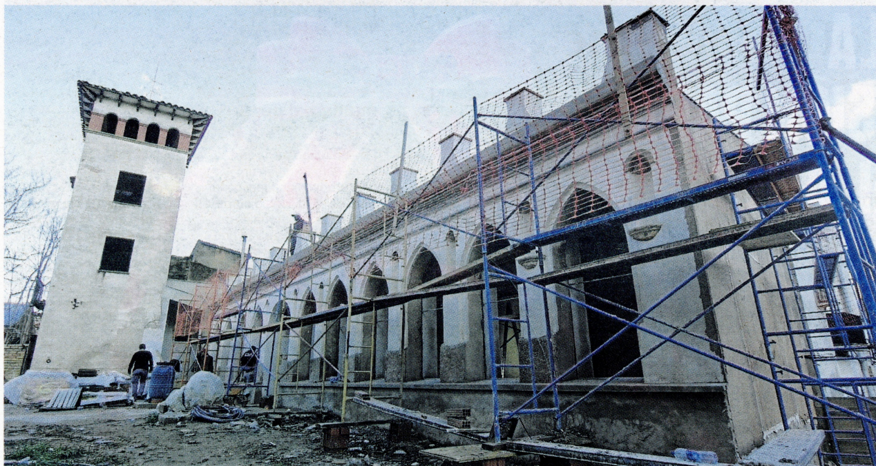
Obres de rehabilitació al pavelló adjacent a la característica torre de l'antic balneari. FOTO: JOAN REVILLAS
