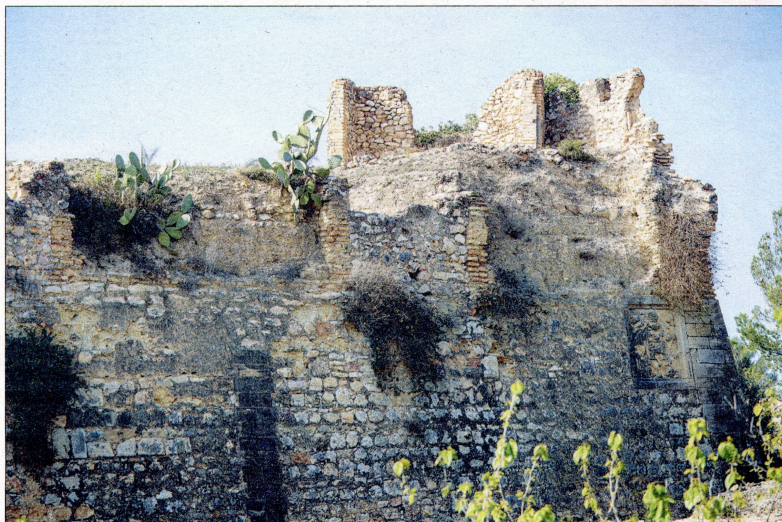
El fortí del Bonet, construït al segle XVII, presenta notables danys en la seua estructura que cal consolidar. /CEDIDA
