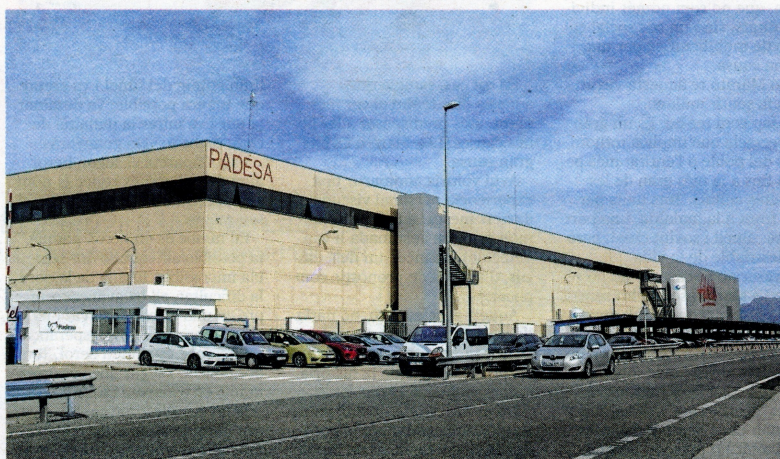
Instalaciones de Padesa en Roquetes, en el Baix Ebre. FOTO: JOAN REVILLAS
