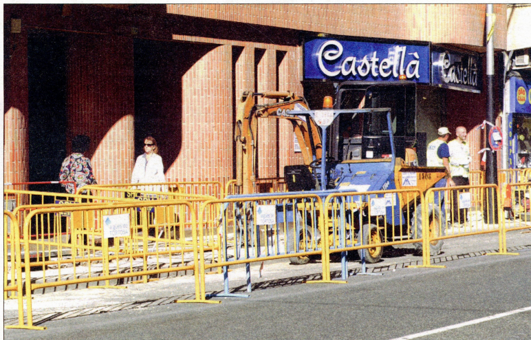
Obres de millora de la xarxa urbana d'abastament d'aigua potable fetes l'any 2018 a l'avinguda Generalitat. / ARXIU
