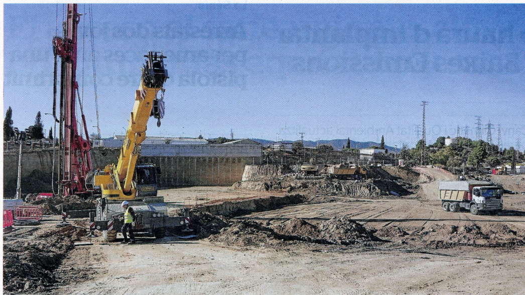
Obres en marxa per construir el magatzem temporal individualitzat de combustible a Ascó, FOTO: J. REVILLAS
