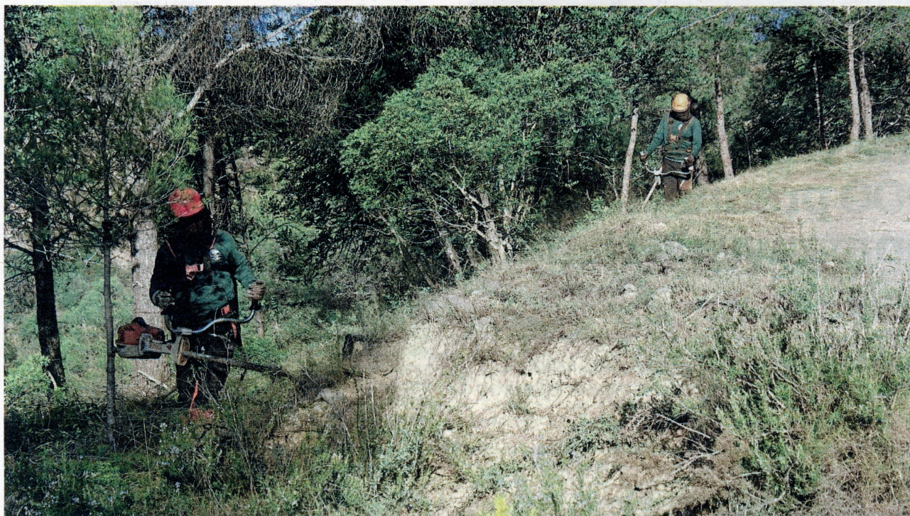
Operaris treballant per obrir les franges auxiliars de trànsit, al terme de Tivenys, ahir al matí. FOTO: J. REVILLAS
