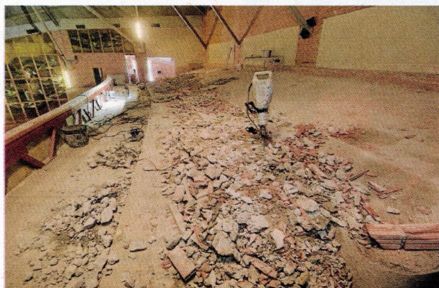
Estat actual de les obres a l'amfiteatre superior de la sala gran.
