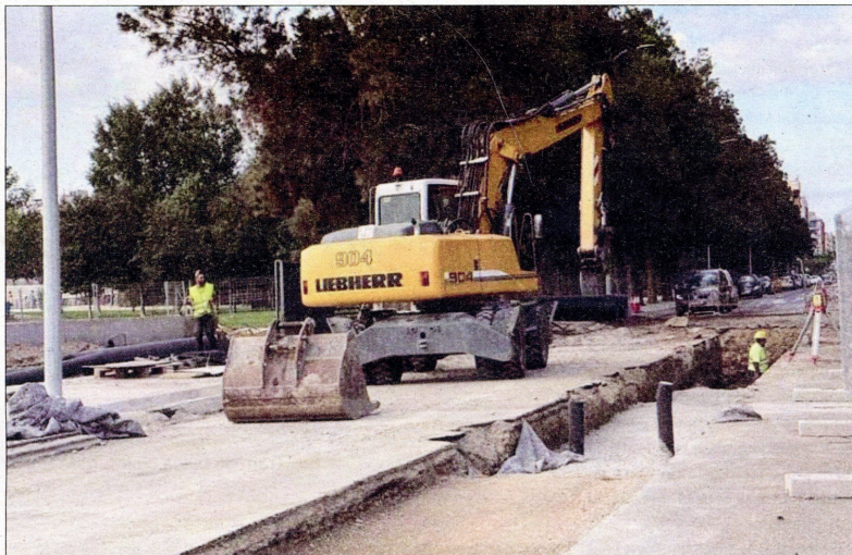
Imatge d'arxiu d'unes obres de renovació de la xarxa d'aigua al carrer Sebastià Juan Arbó. /CEDIDA
