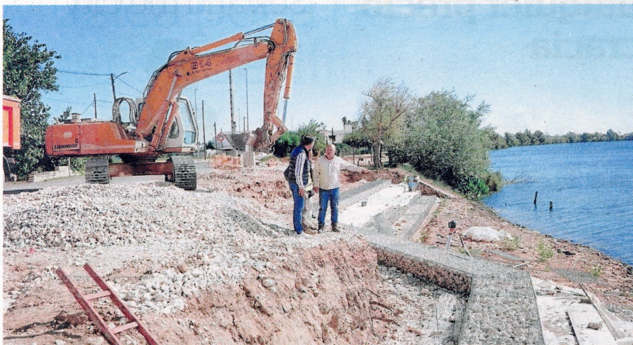
Visita per comprovar l'estat actual de les obres. FOTO: AJUNTAMENT DE DELTEBRE
