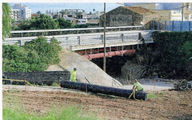
Treballs al pont del barranc del Solito, a la Ràpita, ahir a la tarda.
