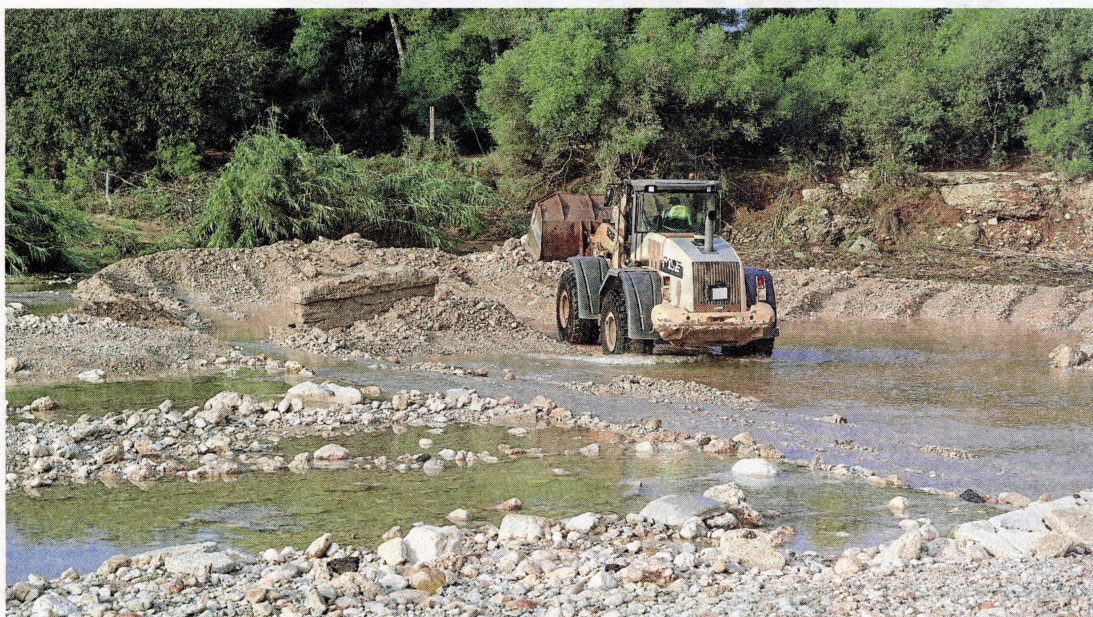
Treballs d'emergència en marxa al barranc de la Galera, a Masdenverge. FOTO: JOAN REVILLAS
