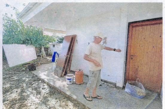
Gilbert, vecino de L'Estona, enseña los daños en su casa. El agua arrasó su comedor y todo el jardín. FOTO: J. REVILLAS
