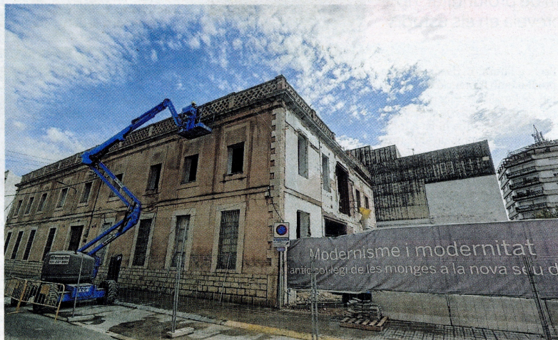
Operaris treballant en la consolidació de l'estructura de l'edifici. FOTO: JOAN REVILLAS
