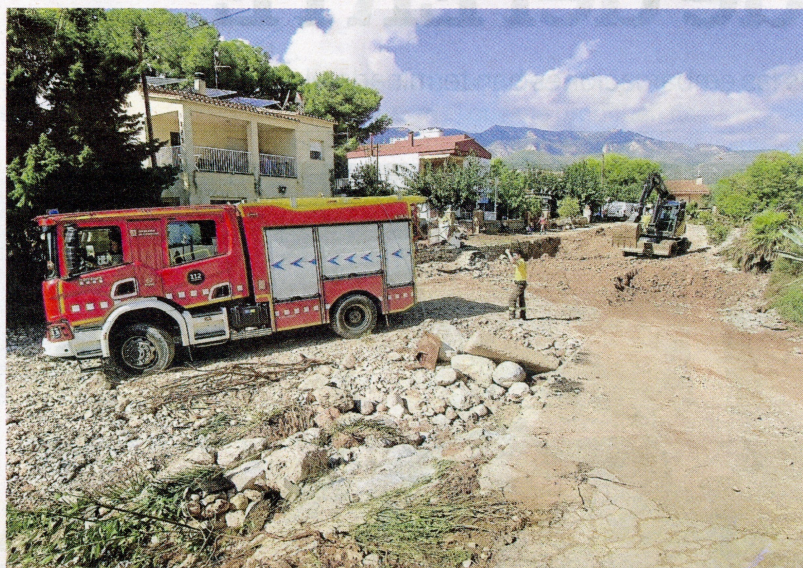
Estado actual del barranco del Suis, entre La Ràpita y Alcanar Platja. FOTO: JOAN REVILLAS
