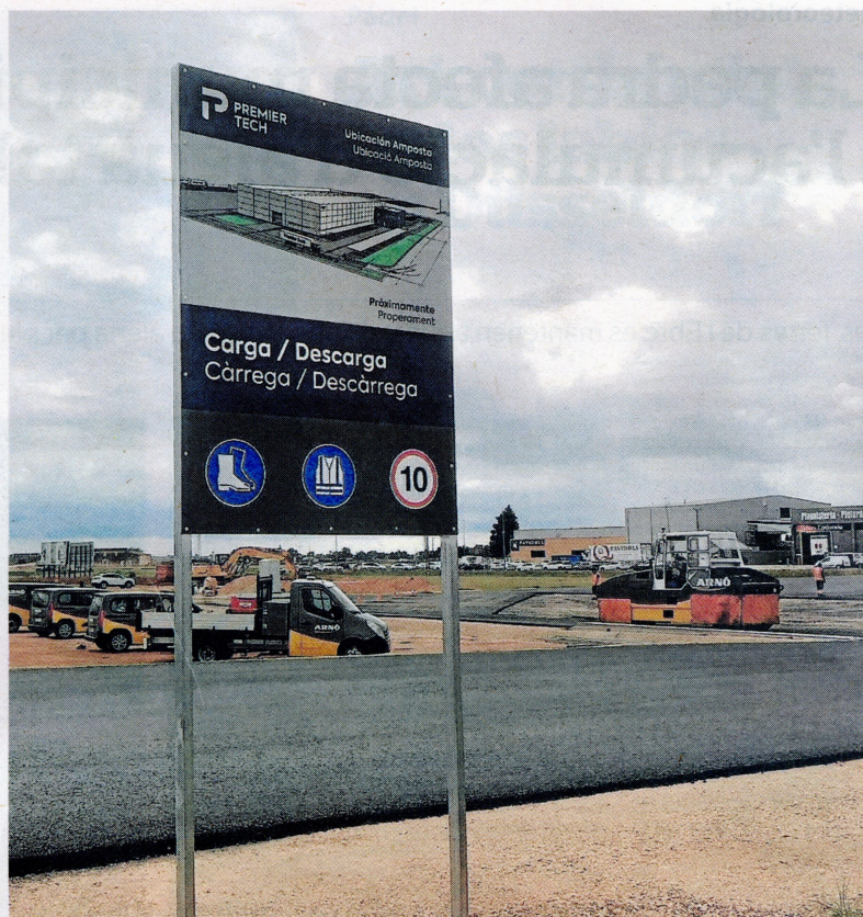
Treballs al solar on s'ubicarà la nova planta. FOTO: M. MILLAN
