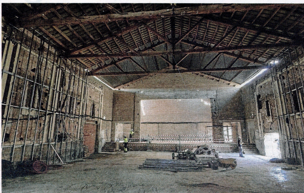
Treballs a l'interior del futur auditori, ahir al matí. FOTO: JOAN REVILLAS
