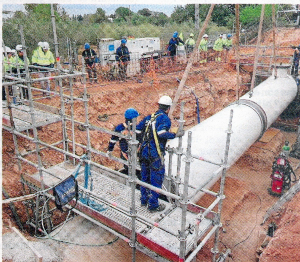
L'actuació permet reduir exponencialment el risc d'incident en l'abastament d'aigua potable al territori. FOTO: CAT
