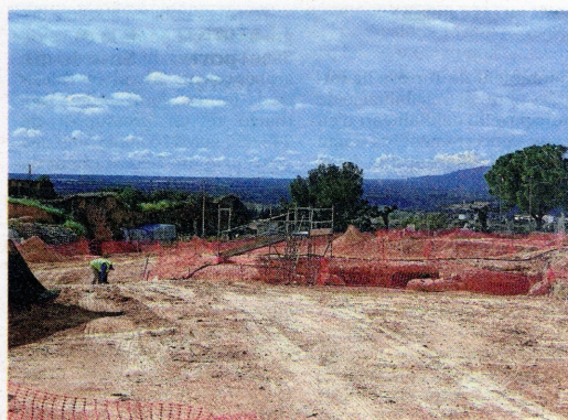
Treballs d'excavació en marxa. FOTO: JOAN REVILLAS
