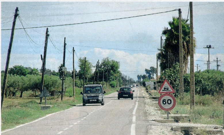
Estat actual de la carretera entre la Ràpita i el Poble Nou del Delta. FOTO:JOAN REVILLAS
