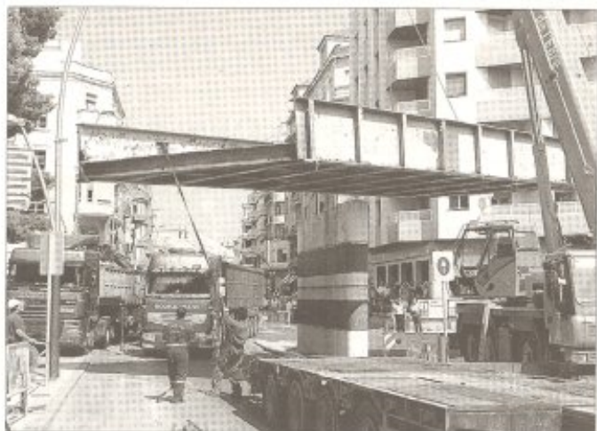
Els treballs de retirada del pont, en desús des del 1996, van aixecar molta expectació.. / CEDIDA
