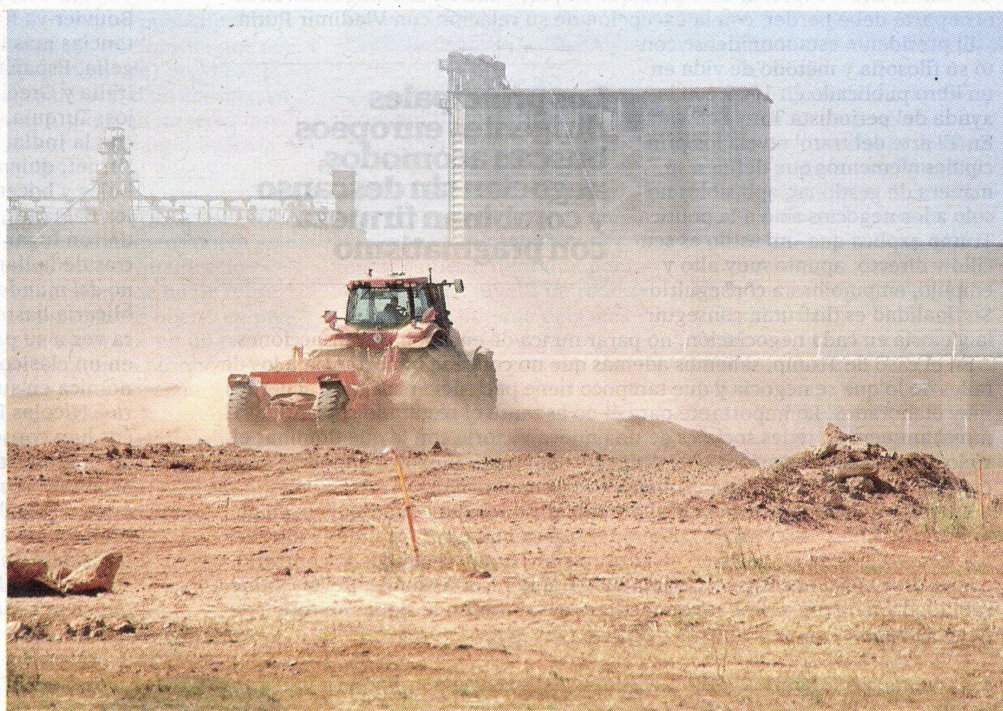
Ja han començat les obres perquè Premier Tech es pugui instal·lar al municipi. FOTO: JOAN REVILLAS
