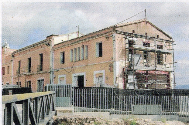
Obres a les cases del Castell d'Amposta, situades a tocar del riu Ebre. FOTO: JOAN REVILLAS
