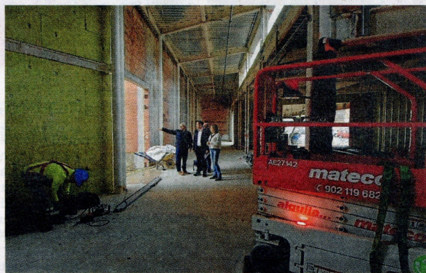
L'actuació de millora de la sala gran principal es licita per 317.000 euros i un termini d'execució dels treballs de quatre mesos. J. REVILLAS
