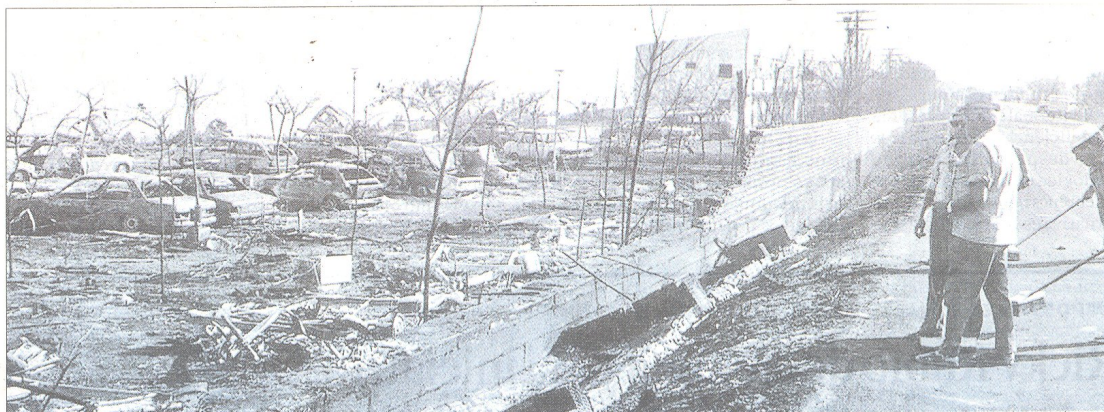
Panoràmica de com va quedar el càmping després de l'explosió del camió cisterna. FOTO: DT
