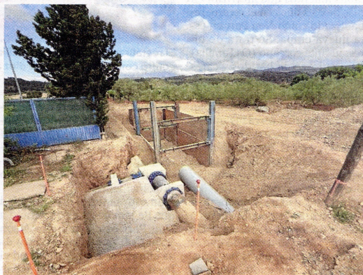
Obres al terme de Móra la Nova. FOTO: JOAN REVILLAS
