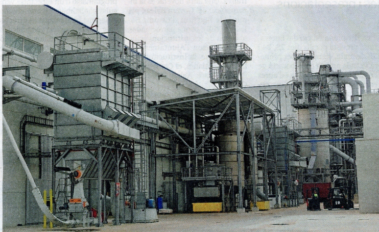
Les instal·lacions de Kronospan al polígon Catalunya Sud, a Tortosa. FOTO: J. REVILLAS
