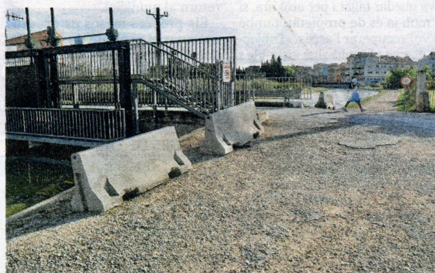
Proteccions al punt de pas sobre el canal de la dreta, al camí del Llorón. FOTO: JOAN REVILLAS
