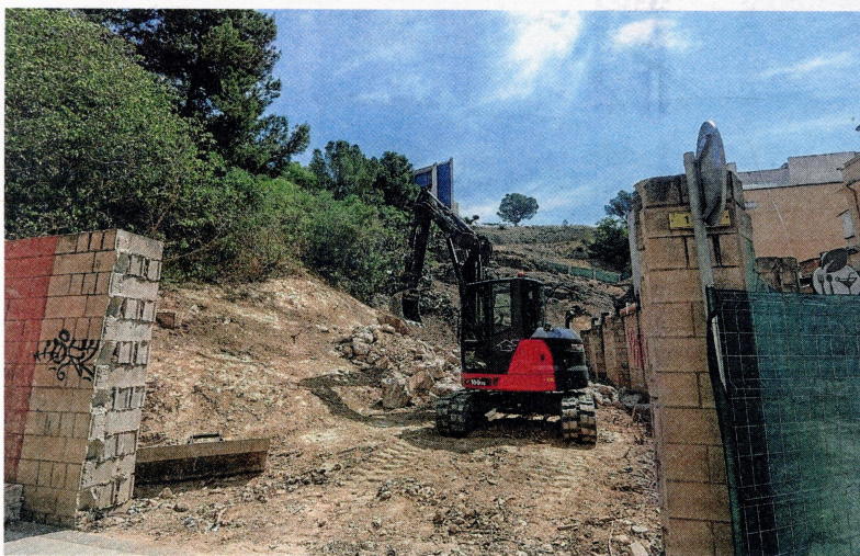
Les obres a la part alta del carrer Teodor González. FOTO: JOAN REVILLAS
