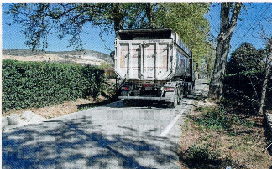
Estat actual de la carretera TV-3313 al seu pas per Ulldecona.
