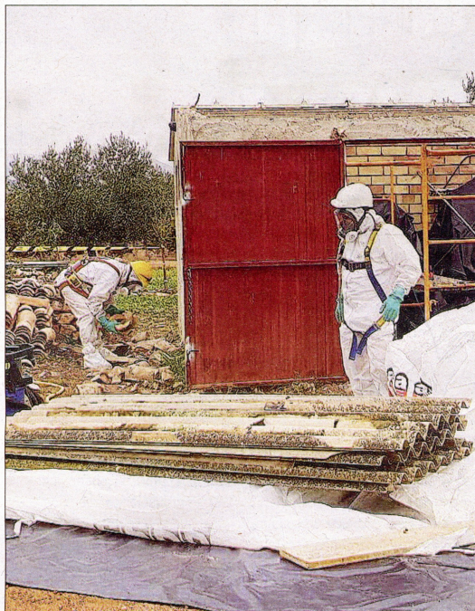
Treballs de retirada de teulades d'amiant realitzats per Also Casals, empresa especialitzada en la retirada d'este material altament perillós. /CEDIDA
