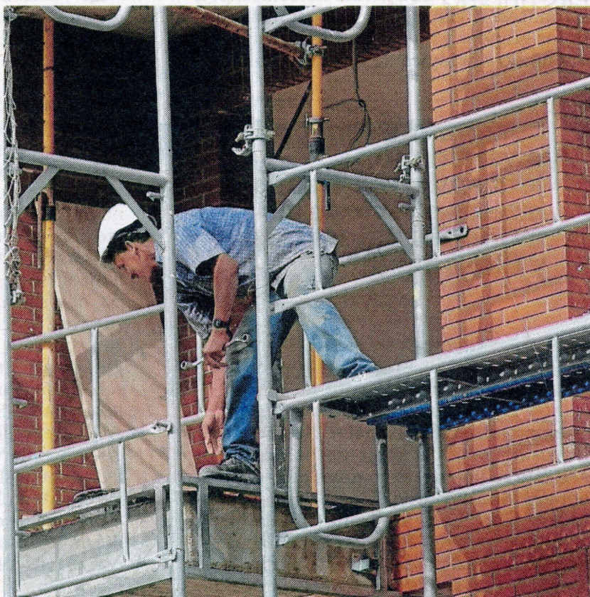
Un operari treballant en la construcció d'un edifici. FOTO: JOAN REVILLAS
